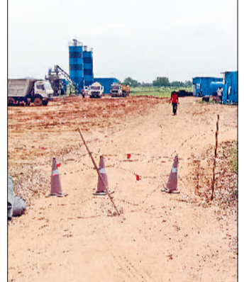
नारनौल। लॉजिस्टिक हब के प्लेटफार्म निर्माण के लिए लगी कंपनी। फोटो: हरिभूमि
